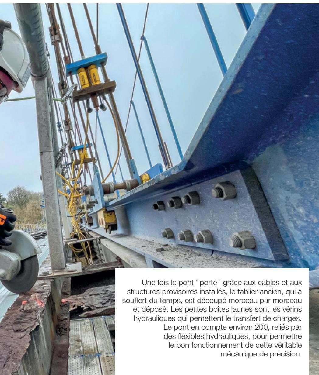
Une fois le pont "porté" grâce aux câbles et aux structures provisoires installés, le tablier ancien, qui a souffert du temps, est découpé morceau par morceau et déposé. Les petites boîtes jaunes sont les vérins hydrauliques qui permettent le transfert de charges. Le pont en compte environ 200, reliés par des flexibles hydrauliques, pour permettre le bon fonctionnement de cette véritable mécanique de précision.
