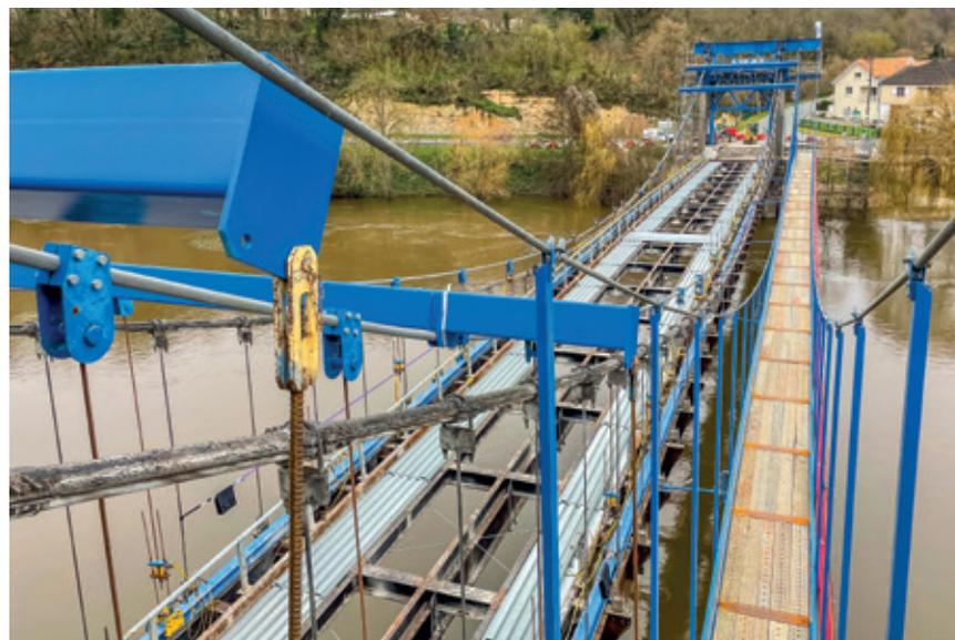
Pour porter le poids du pont, des structures provisoires bleues ont été montées le temps du chantier. Elles seront ensuite enlevées. Les câbles les plus à droite sur la photo servent à soutenir le pont le temps que les câbles anciens soient remplacés. Toute la suspension doit en effet être changée. Après les travaux, le pont sera un peu plus large qu'actuellement, grâce à l'aménagement de deux trottoirs latéraux pour les piétons.
