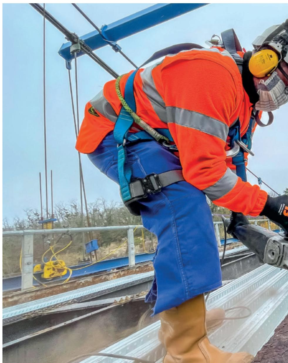
Le tablier métallique du pont a été débarrassé de sa chaussée constituée d'une dalle en béton recouverte de bitume. La chaussée et la structure métallique vont être remplacées en totalité, tandis que les délicates arches de béton style Art Déco du pont, sous la structure provisoire bleue, seront préservées, nettoyées et réparées. L'objectif est de garantir la sûreté des usagers tout en gardant le "cachet" historique de cet ouvrage d'art.
