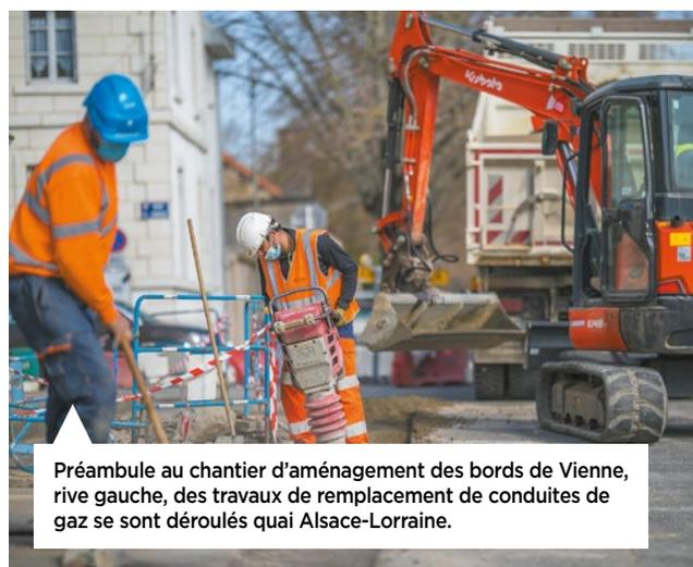
Préambule au chantier d'aménagement des bords de Vienne, rive gauche, des travaux de remplacement de conduites de gaz se sont déroulés quai Alsace-Lorraine.
