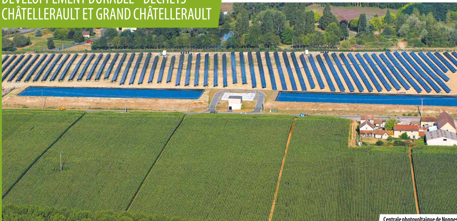
Centrale photovoltaïque de Nonnes
