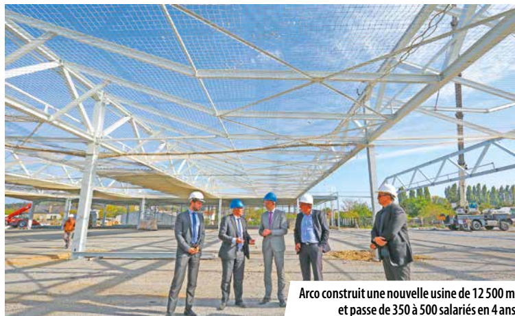
VMH Energies : implantation en 2014 sur l'ancien site de New Fabris
