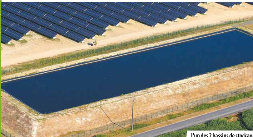
L'un des 2 bassins de stockage
