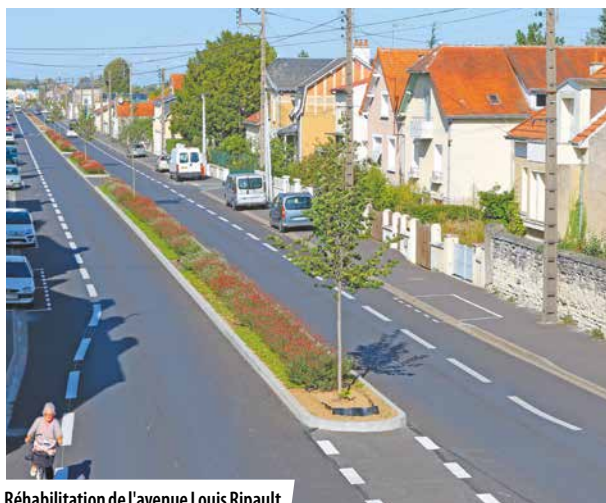
Réhabilitation de l'avenue Louis Ripault
