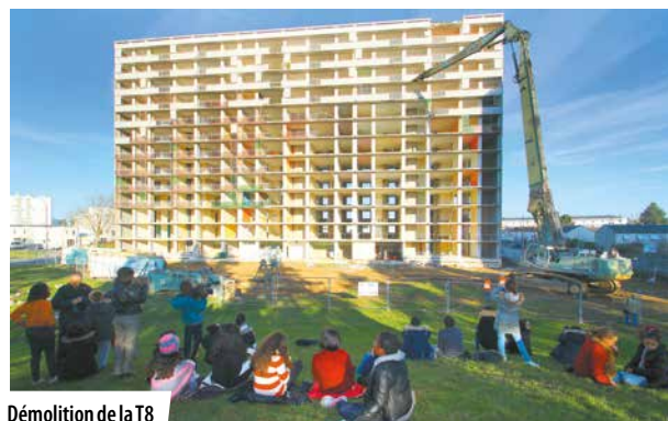
Démolition de la T8
