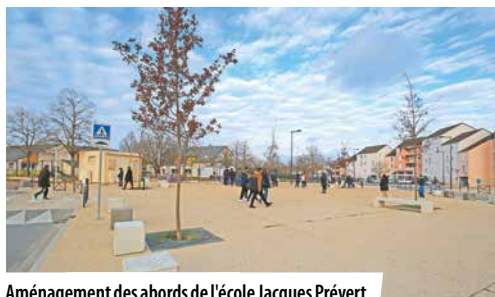
Aménagement des abords de l'école Jacques Prévert
