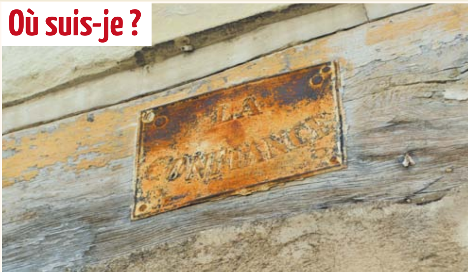
Ancienne plaque d'assurance en tôle encore apposée sur la façade du 31 rue d'Antran à Châteauneuf.
