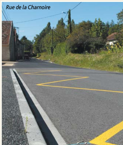
La rue de la Charnoire entièrement refaite : après une 1 re tranche réalisée il y a 2 ans, la dernière a concerné la réfection de la chaussée, l'aménagement d'un chemin piétonnier et la création d'un fossé peu profond pour un montant de 250 000 €.
